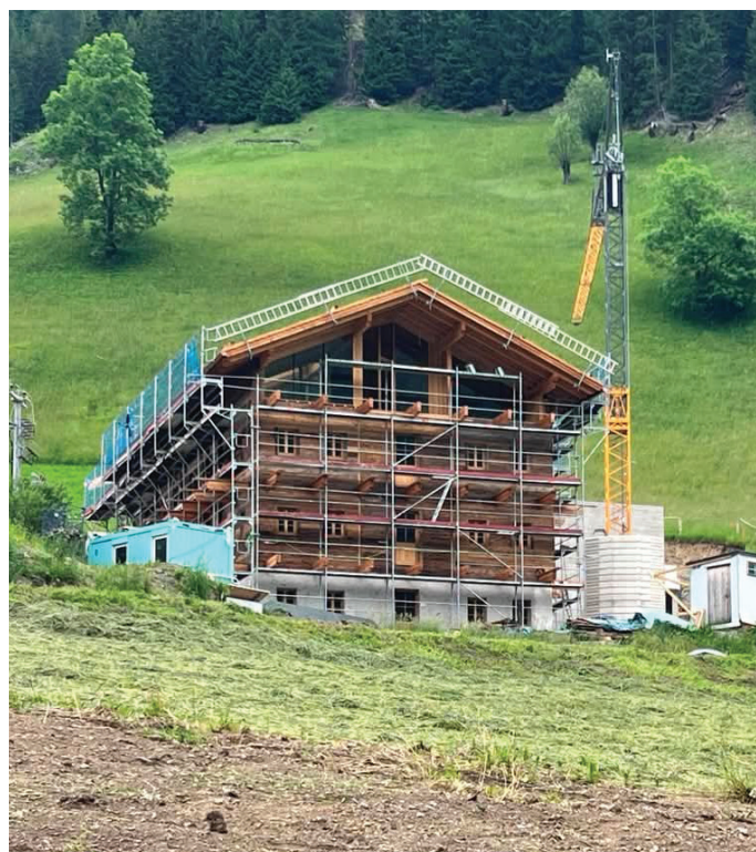
Neubau des Appartementhauses Ausser Lipper GmbH
