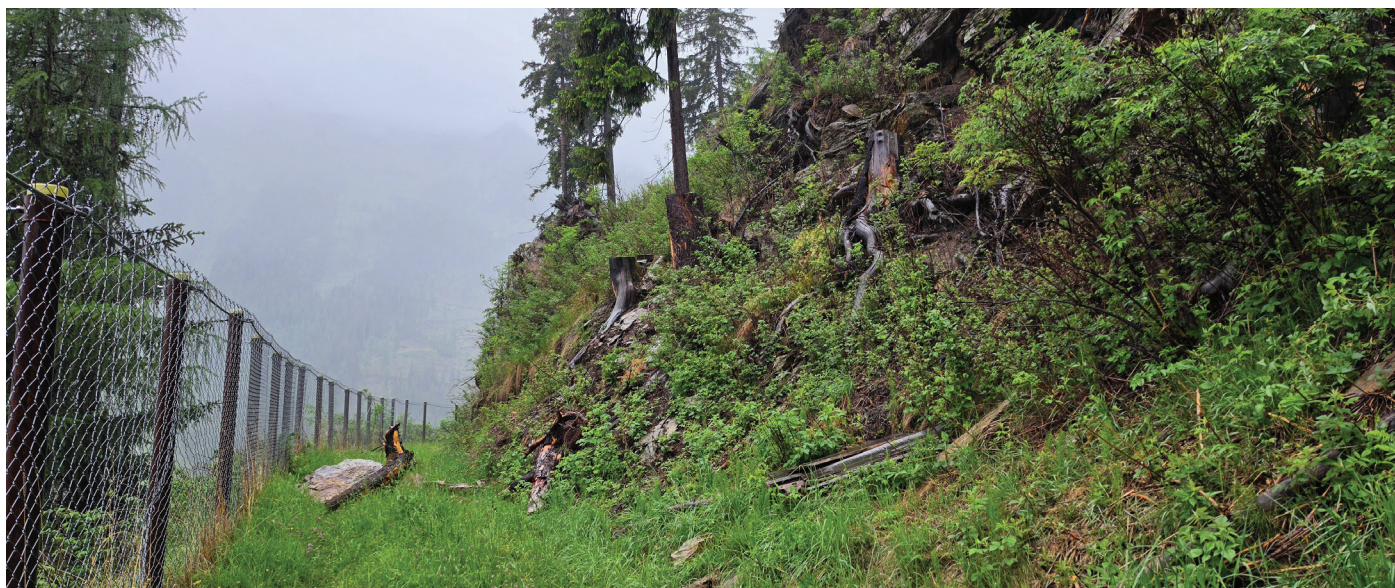
Steinschlagnetz Eggekofl, oberhalb Krakofl
