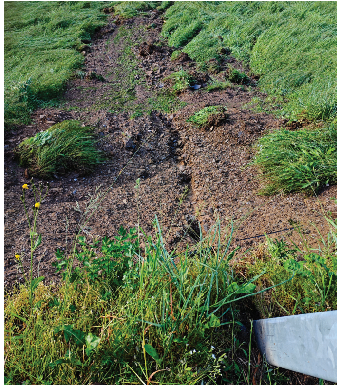
Abbruchstelle im Bereich „Gruber“
