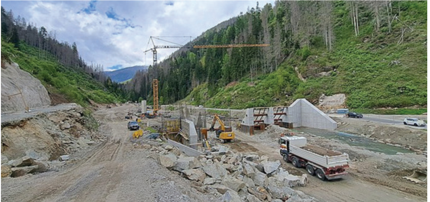
Die Arbeiten schreiten voran © Land Tirol
