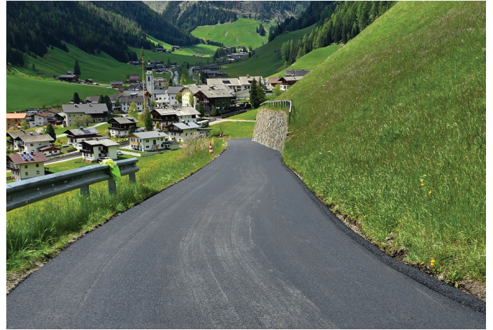
Neu asphaltierte Teilstrecke der Ahornbergstraße
