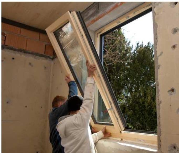
Der Fenstertausch wird idealerweise gemeinsam mit der Fassadendämmung durchgeführt – dadurch können die Anschlüsse optimal und wärmebrückenfrei ausgeführt werden.
