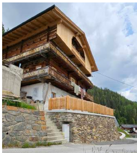
Sanierung Gemeindestraße „Kleinbachlet“
