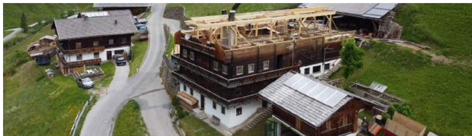
Erneuerung des Dachstuhl's beim „Peintnerhof“
