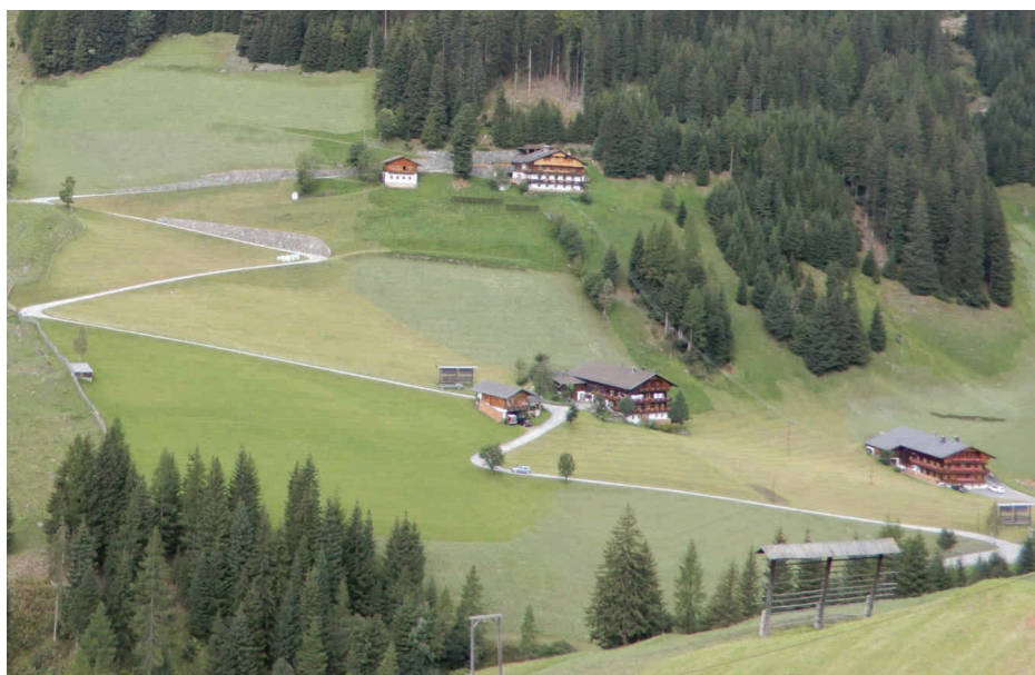
Die Straße weist altersbedingt bereits gravierenden Fahrbahnschäden auf
