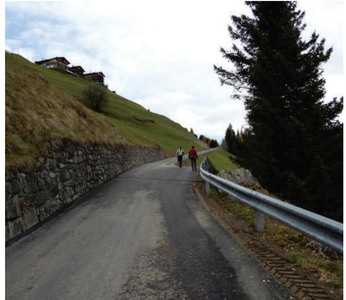
Der Einbau einer stabilen Tragschicht war ebenso unerlässlich wie die Errichtung von Leiteinrichtungen.
