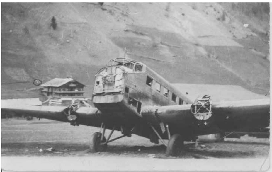
Die JU 52 - die Motoren sind bereits abmontiert
