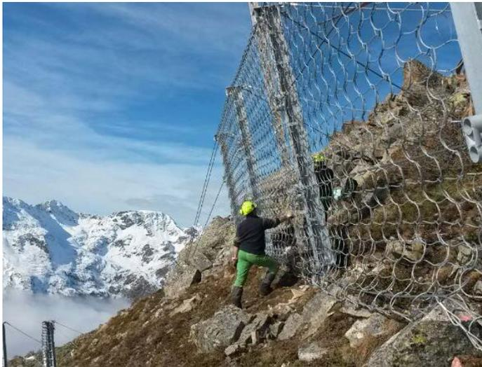
Steinschlagschutznetz Trumer H= 4.0m, 2000 kj
