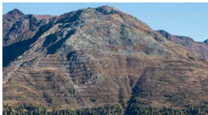
Gesamtübersicht der Lawinenverbauung
