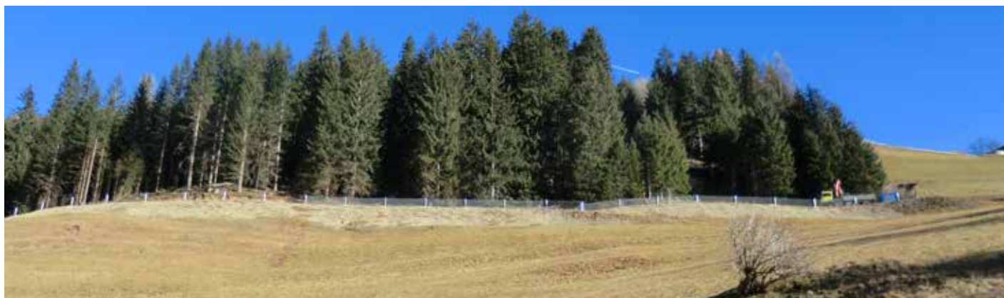
Bauarbeiten zur Steinschlagsicherung Lahnberg
