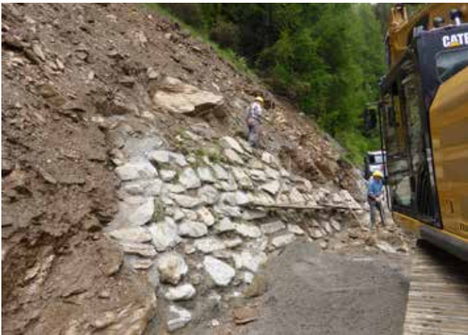
Bergseitige Böschungsstabilisierung
