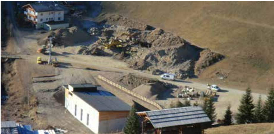
Die Baustelle beim Krafthaus
