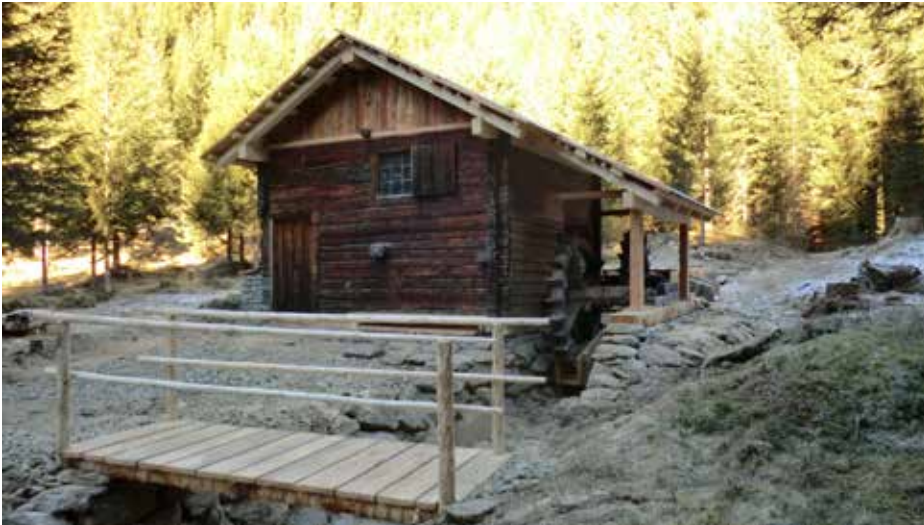
Die neuerrichtete Lüftermühle
