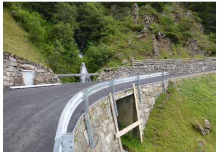
Gosebächquerung mit neuen Leitschienen
