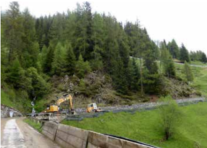
Talseitige Böschungsverstärkungen
