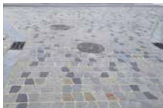
Natursteinpflaster gespalten Aspekt Nachhaltigkeit: Verwendung von Reuse-Pflaster
